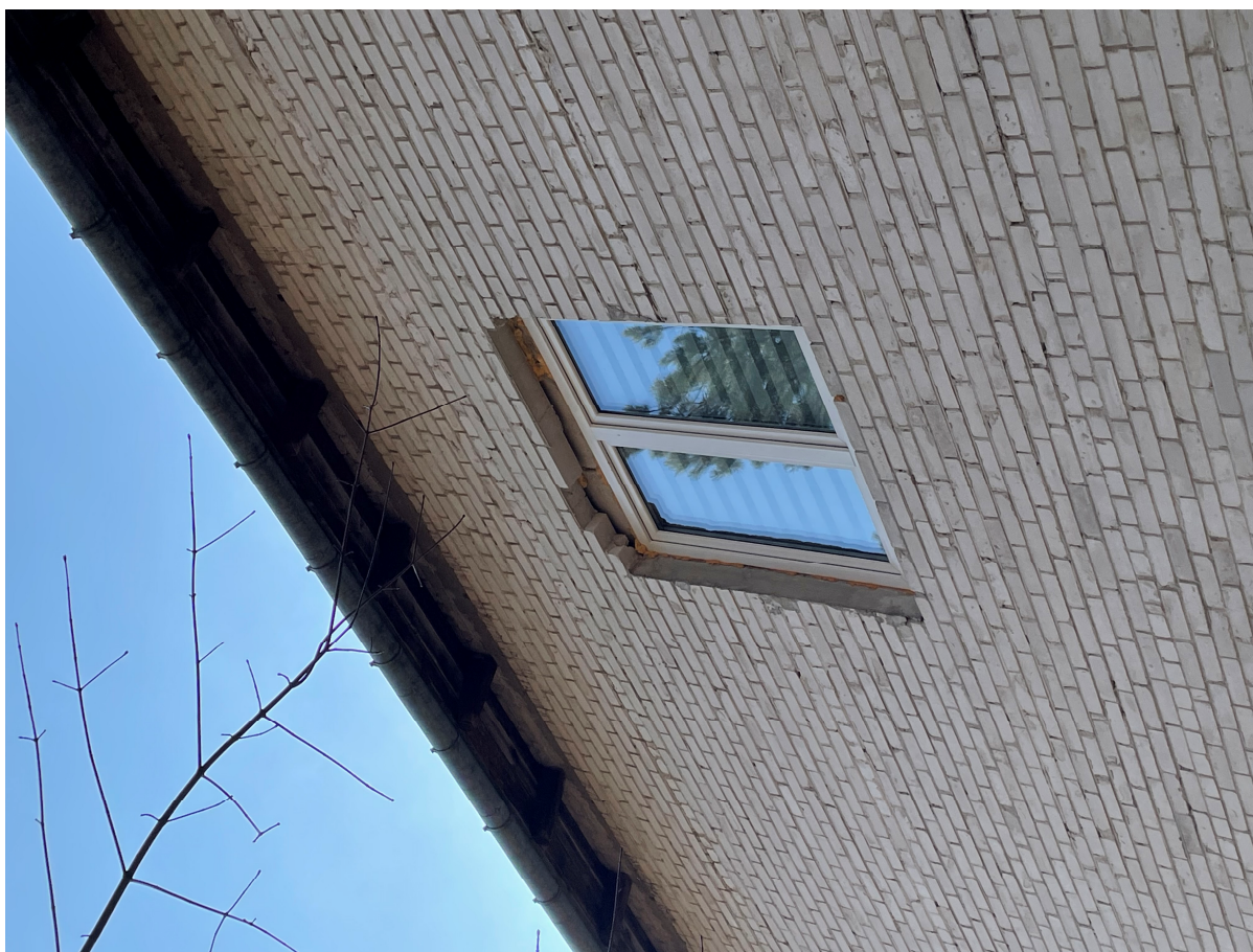
Foto nr 5 – nadproże nad oknem do wzmocnienia kątownikiem stalowym
