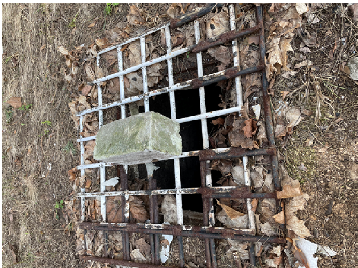
Foto nr 4 – pokrywa zbiornika do wymiany na drogową typu lekkiego
