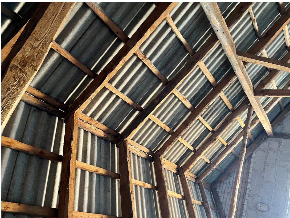
Foto nr 7 – więźba dachowa do pozostawienia, płyty eternitowe do rozbiórki
